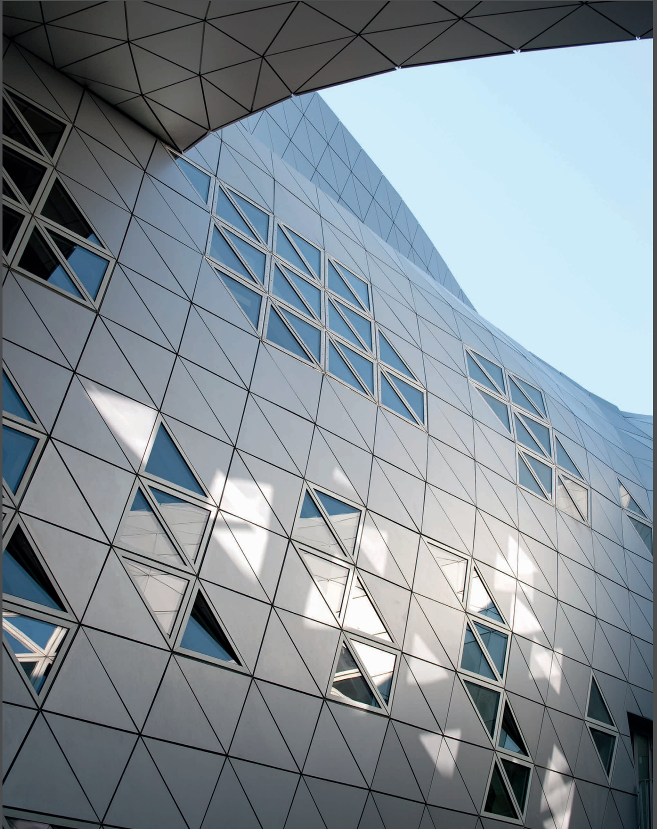
Lycée Georges Frêche, Francia | Architetti: Massimiliano e Doriana Fuksas, Roma, Parigi | Trasformatore: Tim Composites, SMAC Toulouse Materiale: ALUCOBOND® anodized look C0/EV1 | Foto: © Moreno Maggi
