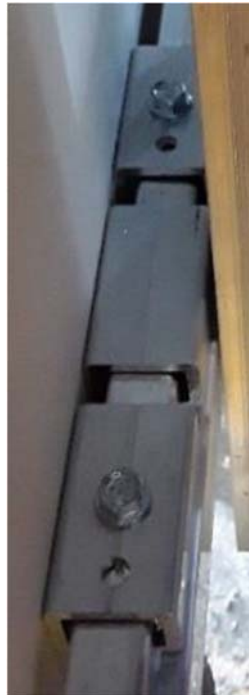
Figure B4- vue des agrafes de blocage basse anti-dégondage
