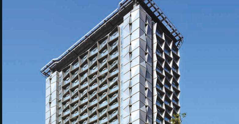
**Les panneaux composites en aluminium ALPOLIC™ A2 sont composés de deux tôles d'aluminium de 0,5 mm d'épaisseur, fixées sur un cœur minéral incombustible à l'aide d'un procédé de fixation par fusion.**
